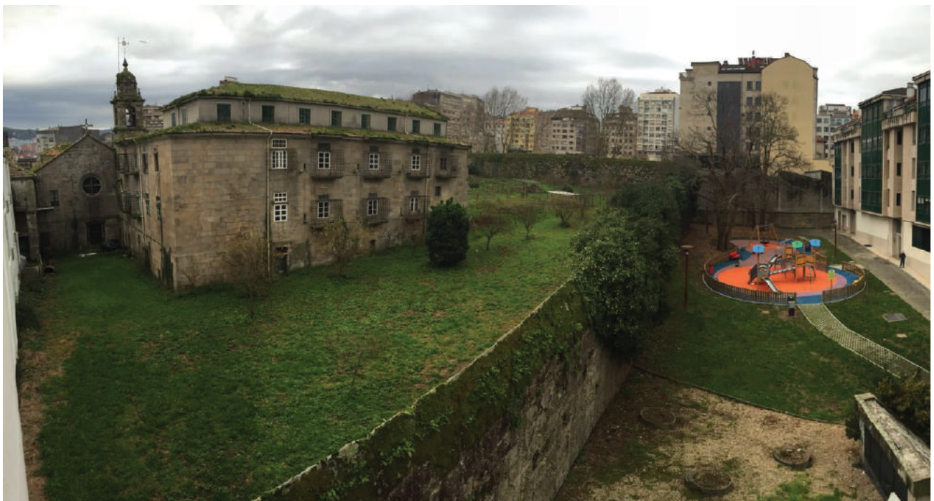
Foto 2: Arredores do edifício
